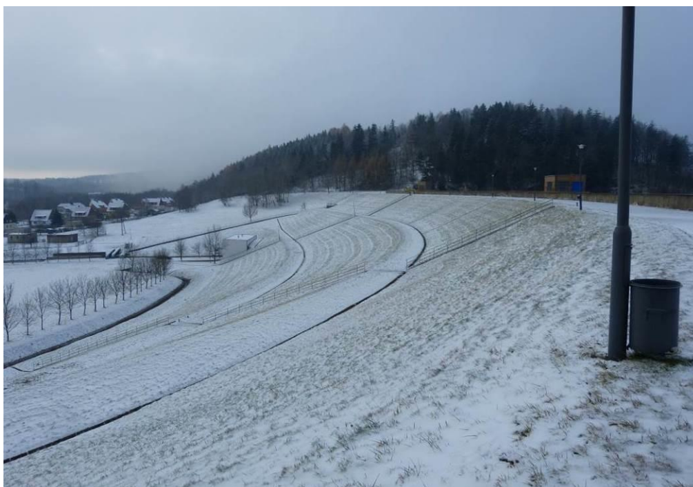
Fot. 2.2. Widok ogólny na ścianę odpowietrzną.
