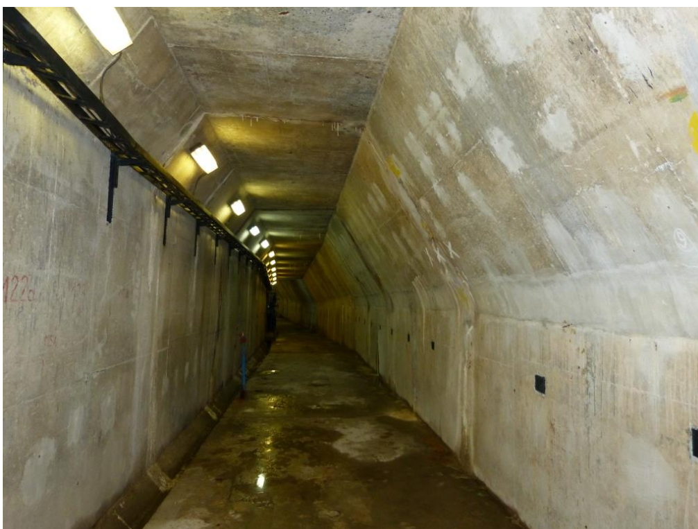
Fot. 2.8. Widok ogólny na wnętrze galerii kontrolnej.
