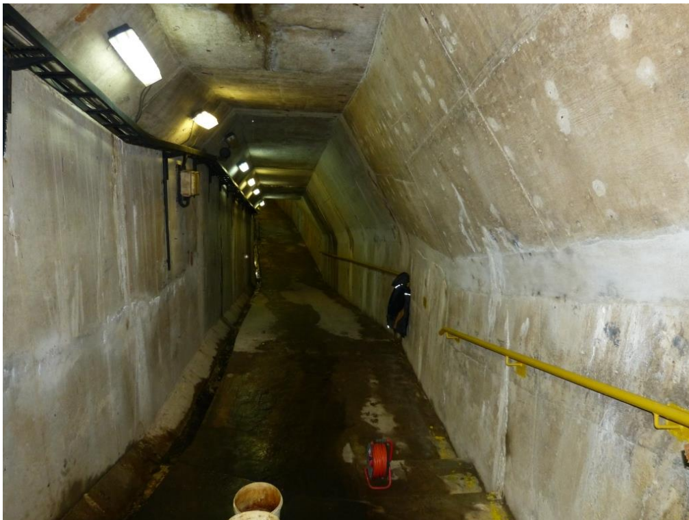
Fot. 2.9. Widok ogólny na wnętrze galerii kontrolnej.
