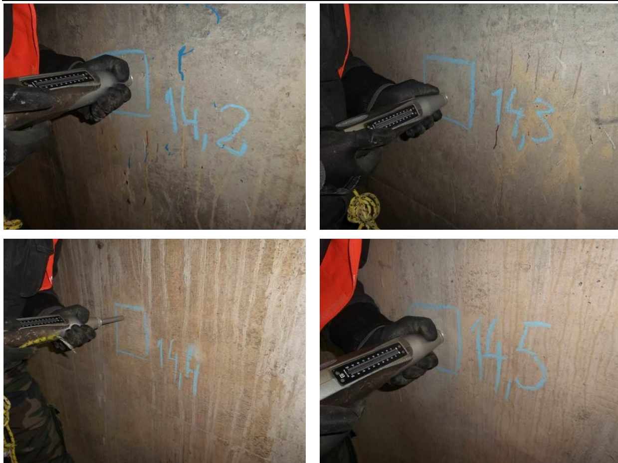
Fot. 4.2. Przykładowy widok na przebieg badań sklerometrycznych betonu
