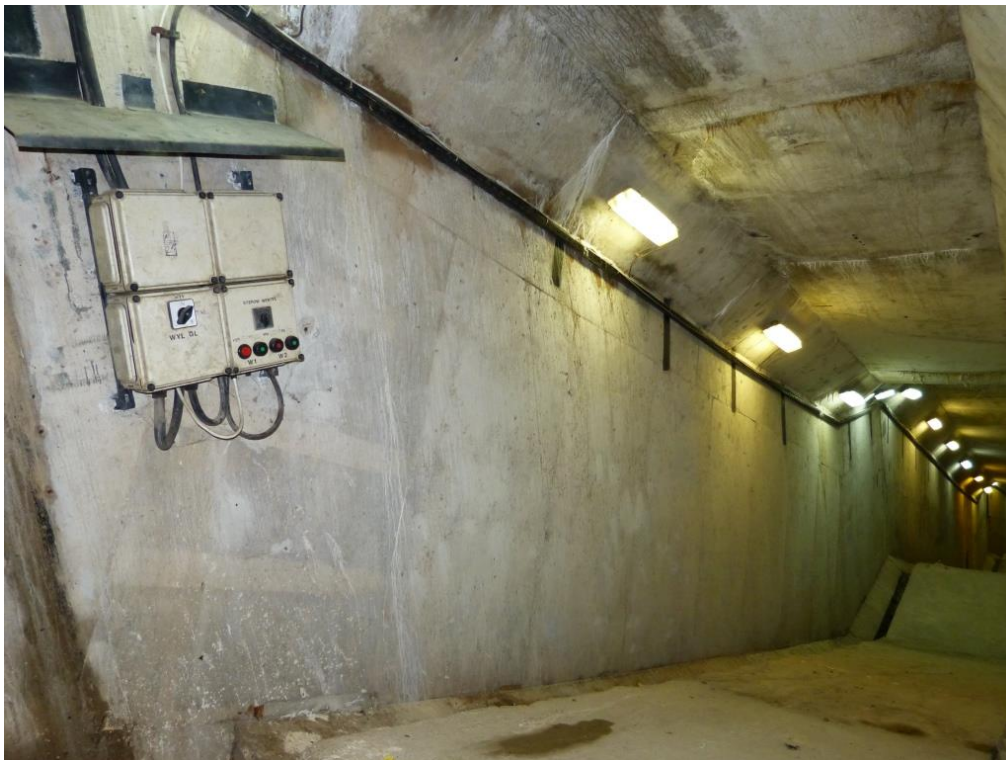
Fot. 2.7. Zdjęcie przedstawiające zejście do galerii kontrolnej.
