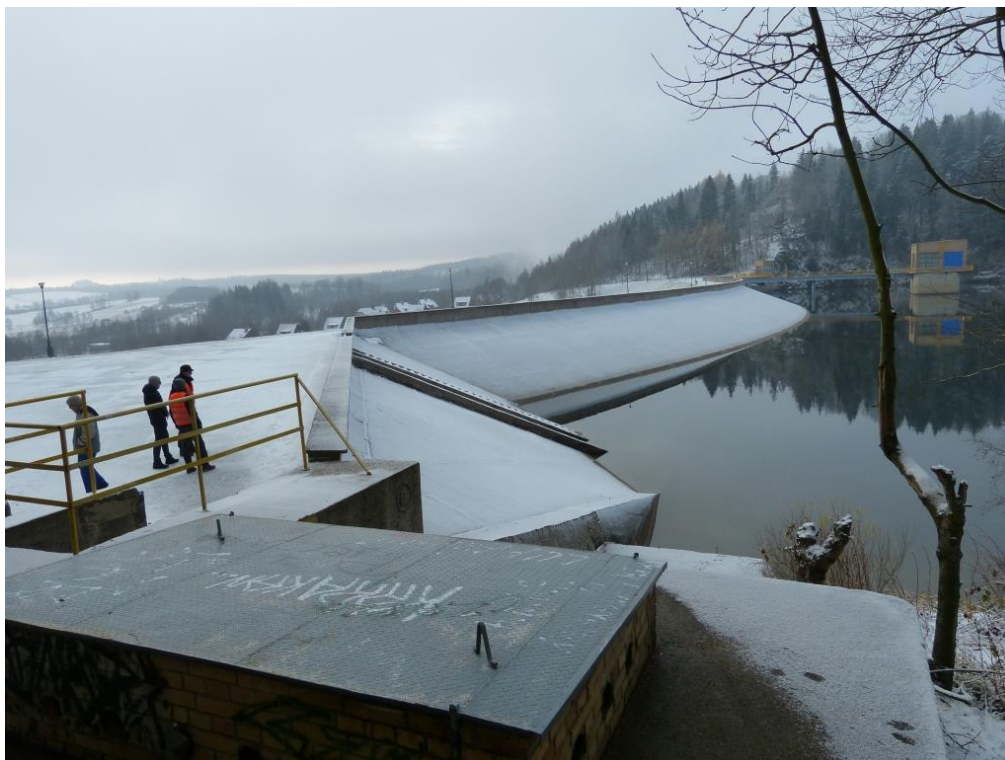
Fot. 2.1. Widok na zapórę od strony wody górnej
