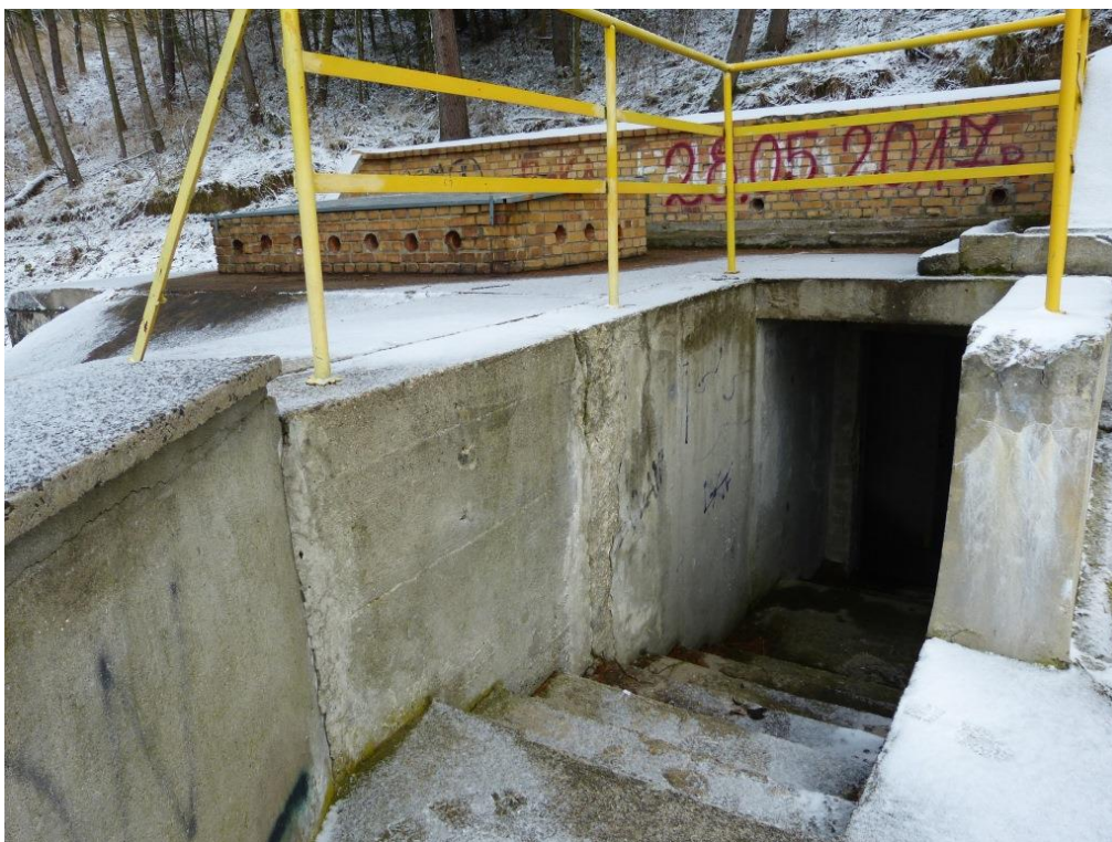
Fot. 2.6. Zdjęcie przedstawiające wejście do galerii kontrolnej.
