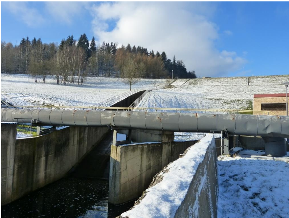
Fot. 2.3. Widok ogólny na przelew powierzchniowy.
